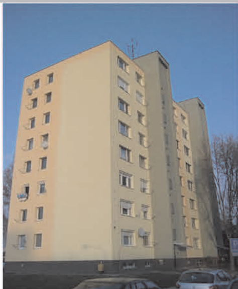
Zateplenie byt.domu Gen.Klapku 3,5 Komárno
